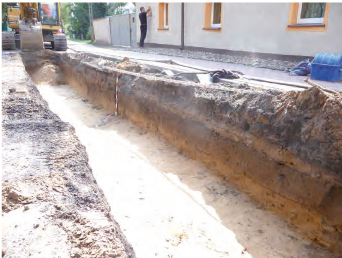
Ryc. 26. Ptaszkowo, gm. Grodzisk Wielkopolski, stan. 1. Wykop główny – odcinek II. Ściana południowa. Fot. S. Pruchnik
