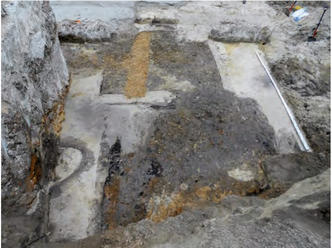
Ryc. 14. Poznań, ul. Dominikańska nr 9 – budowa domu mieszkalno-usługowego. Badania i nadzory archeologiczne 2014. Wykop nr I/14. Relikty zespołu budynków: chaty wzniesionej w konstrukcji zrębowej (obiekt nr 2 – po stronie lewej) i domu zbudowanego w konstrukcji szkieletowej (obiekt nr 1 – po prawej stronie) na poziomie 55,00 – 55,20 m n.p.m. W dolnym, prawym narożniku pozostałości odstożnika na wodę (obiekt nr 3). Druga połowa XIV wieku. Ujęcie od W, z góry. Fot. P. Banaszak
