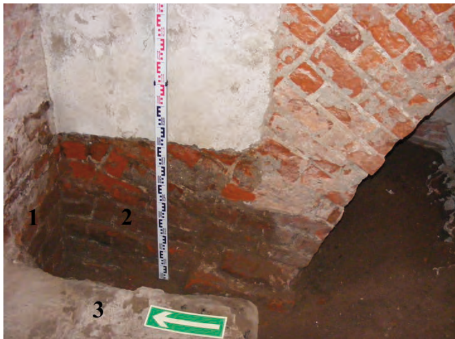
Ryc. 3. Piwnice pod spichlerzem - wykopy 9/2007 i 9a/2009, odkrywki II/2007 i III/2007 (wyk. T. Olszacki, 2009).
